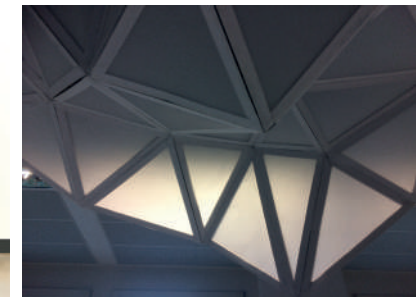
Einbettung eines Akustikelements
